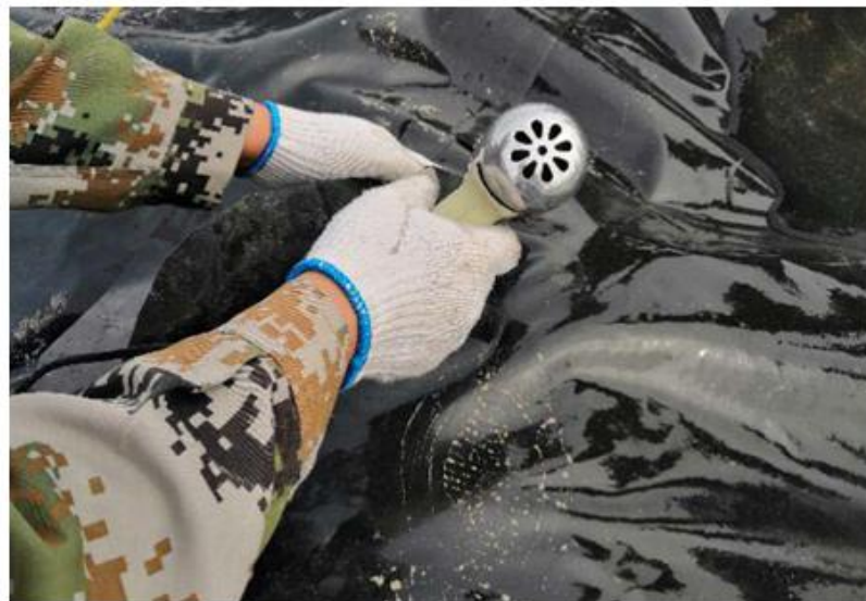
场外施工用地建设
